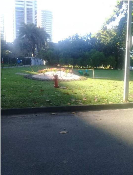
Funcionário executando novo canteiro.
