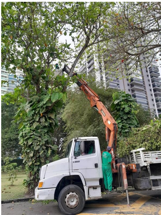
Poda e remoção de ervas de passarinho, com auxílio do caminhão guindaste.
