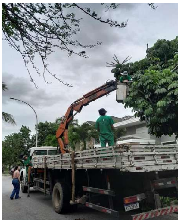
Poda com auxílio do caminhão guindaste.
